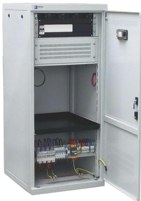
El **RAF Ilion-O** va asociado al controlador **Orion**, que ofrece una gran facilidad de monitorización y configuración del rectificador, tanto en local mediante su display LCD táctil, como remotamente mediante gestor web, SNMP o Modbus.
